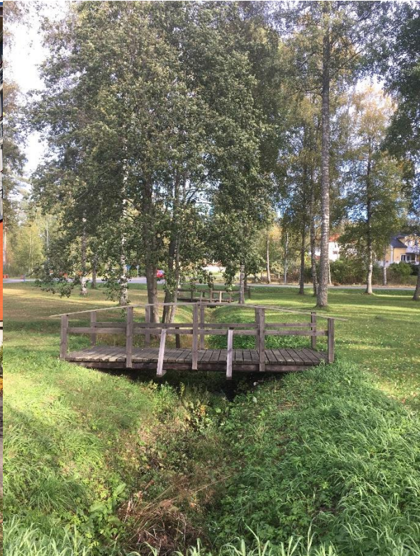
Figur 26 Öppen avledning i dike
