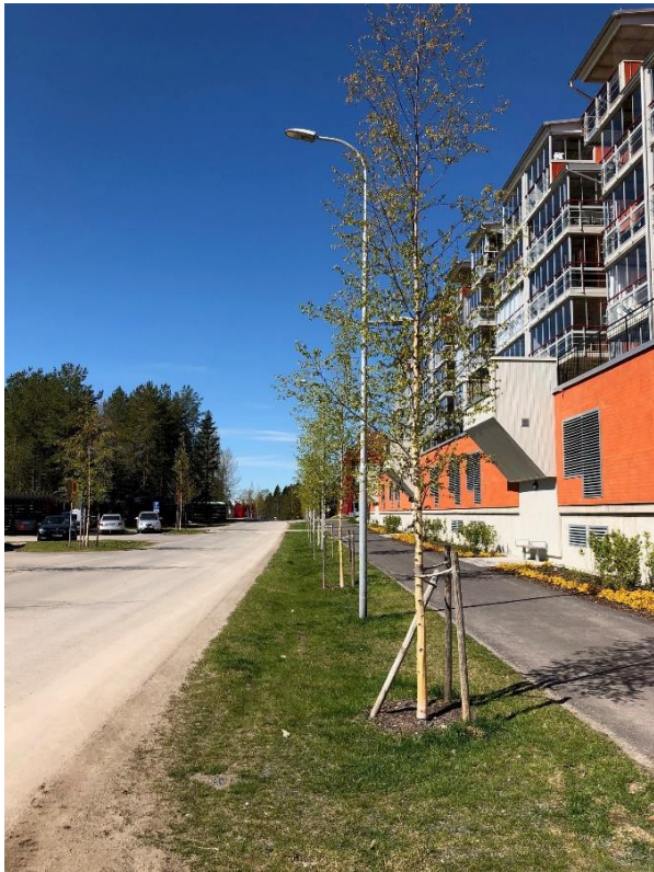
Figur 25 Öppen avledning i svackdike
